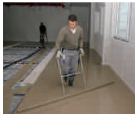
Ein anspruchsvolles Gemeinschaftswerk: Der Heizestrich.
