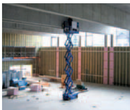
Arbeiten auf einer schweren Hebebühne.
