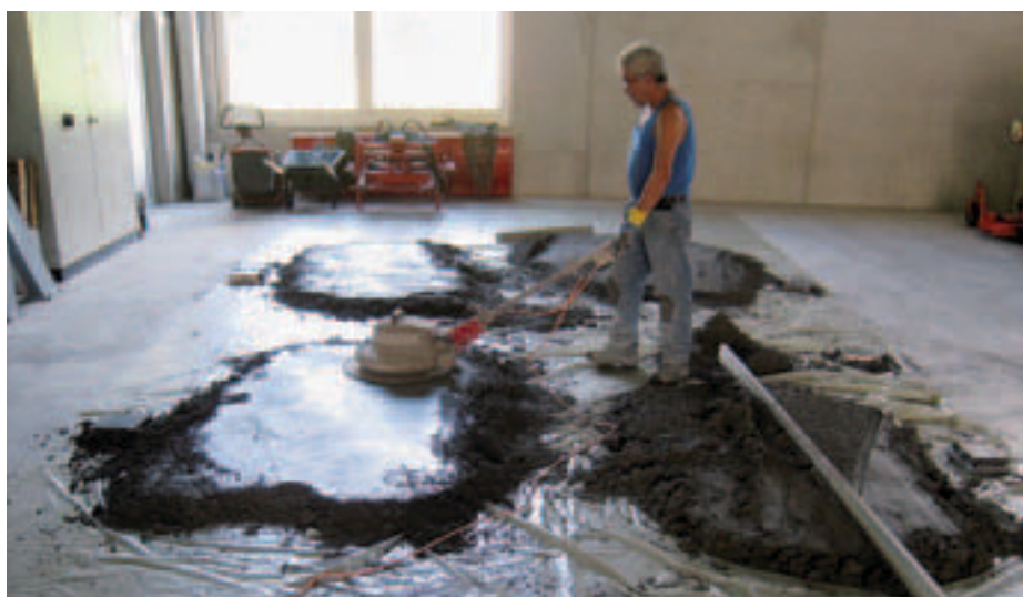
Herstellen des Estrichmörtels, verdichten und glätten.
