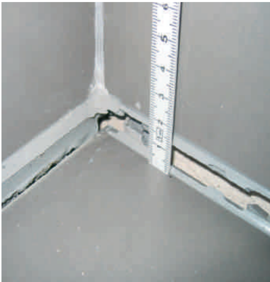
Es gibt bislang keinen Fugendichtstoff, welcher eine Dehnung von mehr als 25 Prozent des Fugenquerschnitts aufnehmen kann.
