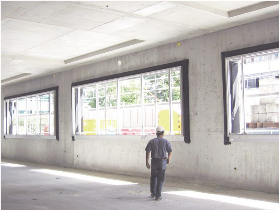
Freihängend verklebte Abdichtungsfolie (Membranfolie) im Innern.
