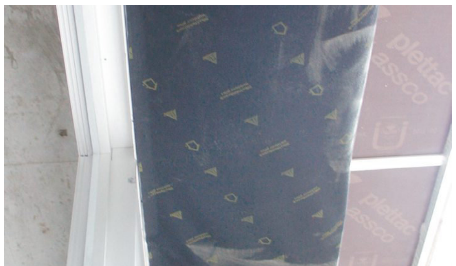
Freihängend verklebte Abdichtungsfolie (Membranfolie) aussen.
