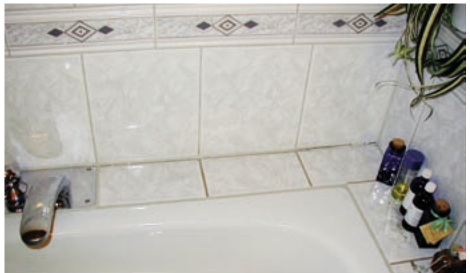
Fugen zwischen Bade-/Duschwannenrand und Wand gehören im Sanitärbereich zu den am stärksten belasteten.
