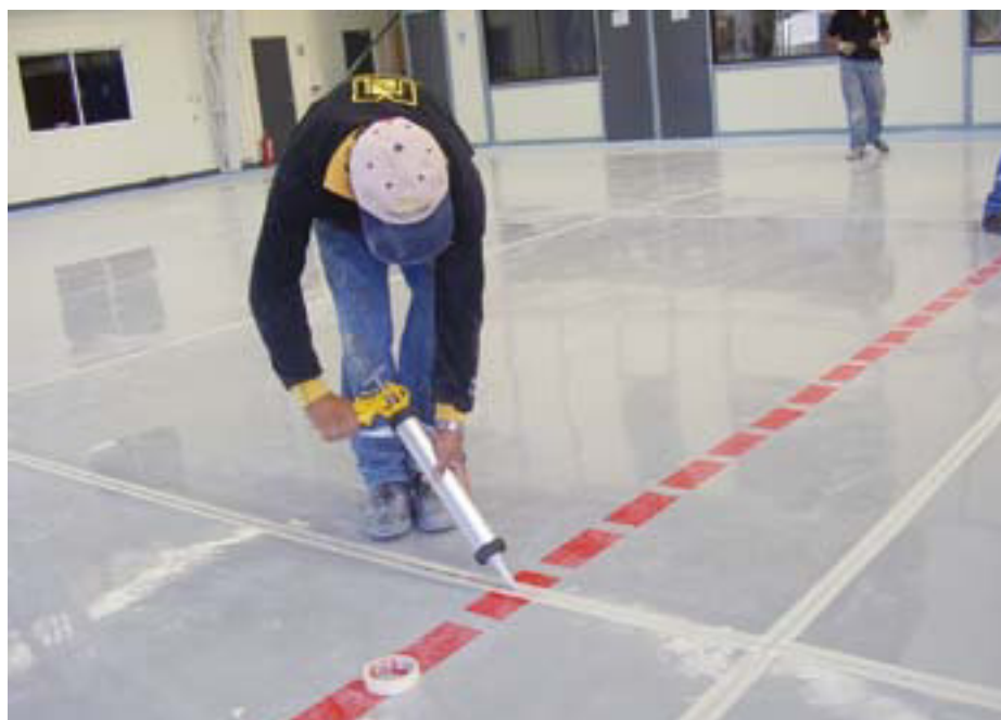
Verarbeitung einer Bodenfuge.
