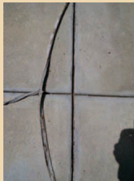
Quelle est la cause de la défaillance de ce produit de jointoyage?
