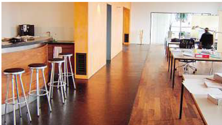
Abb. 3: Hochmodernes Design mit Gussasphalt im Pionierpark in Winterthur: Gussasphalt natur kombiniert mit Parkett.
