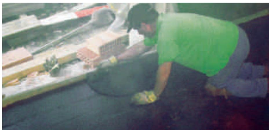
Radonbelastete Kellerräume können mit einem Gussasphaltestrich abgedichtet werden.
