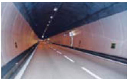
Mit einem hellen Fahrbelag im Tunnel lassen sich bis zu 40% Energie für Beleuchtung einsparen.
