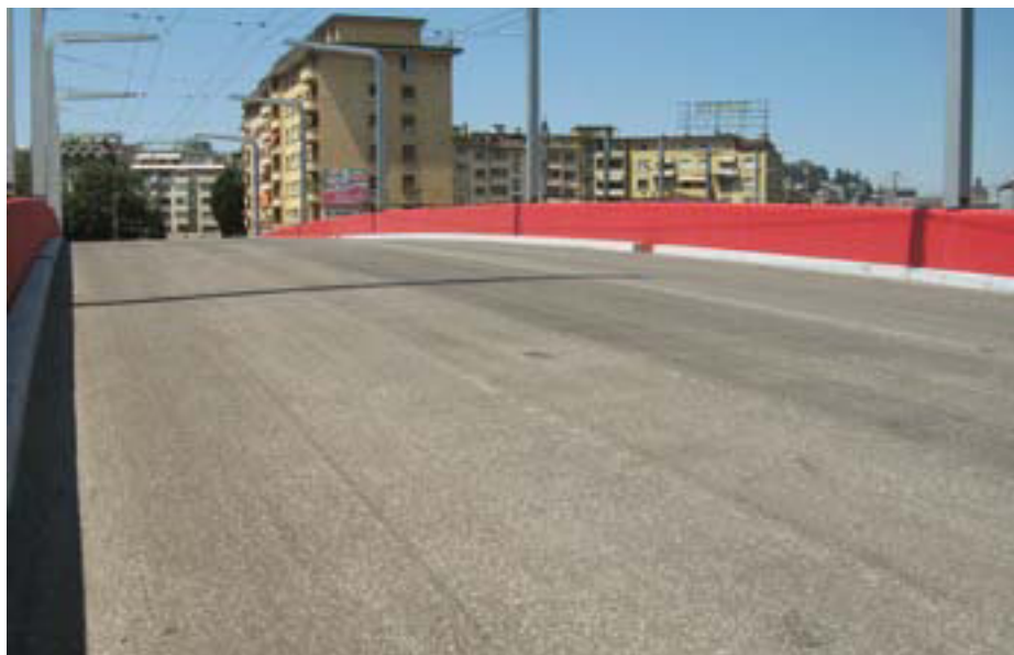
Helle Beläge spiegeln weniger als dunkle Beläge, zudem erhitzt sich die Oberfläche deutlich weniger.
