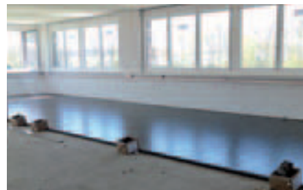
Gussasphalt als schwimmender Estrich im Innenbereich.
