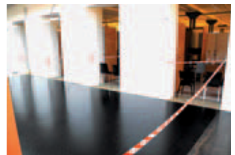
Wo zugänglich, sollten die Abdeckbänder sofort entfernt und die bearbeiteten Flächen durch Absperrbänder geschützt werden.
