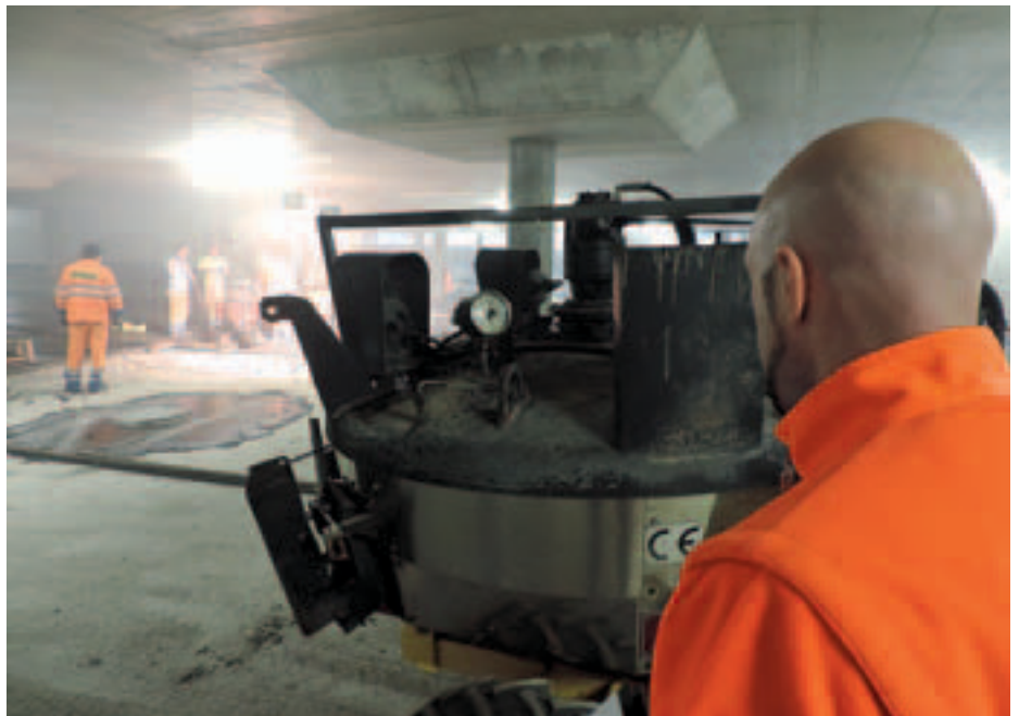
Beim Gussasphalt ist von grosser Bedeutung, mit welcher Temperatur es eingebaut wird.
