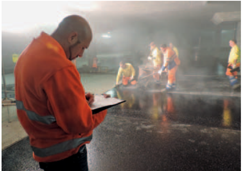
Die Einbaukontrolle ist ein genaues Protokoll zu Messwerten und Beobachtungen.
