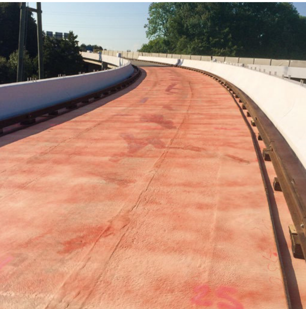
Abdichtung der Fläche mit Flüssigkunststoff.
