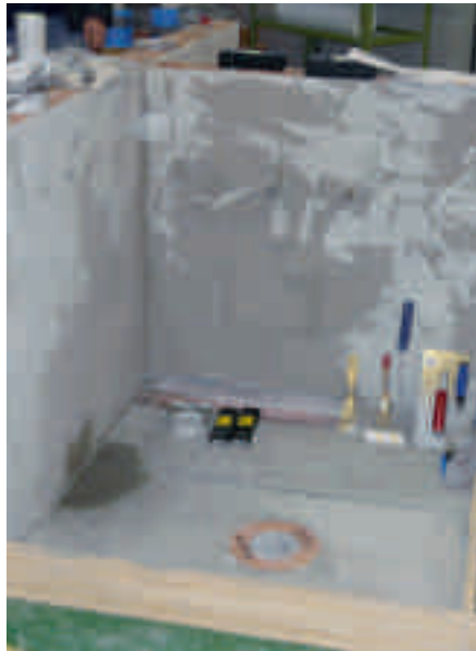
Eine Musterecke mit schwimmendem Estrich, Randstreifen, Fuge, Rohrdurchdringung, Ablauf und schallgedämmter Entwässerungsrinne.
