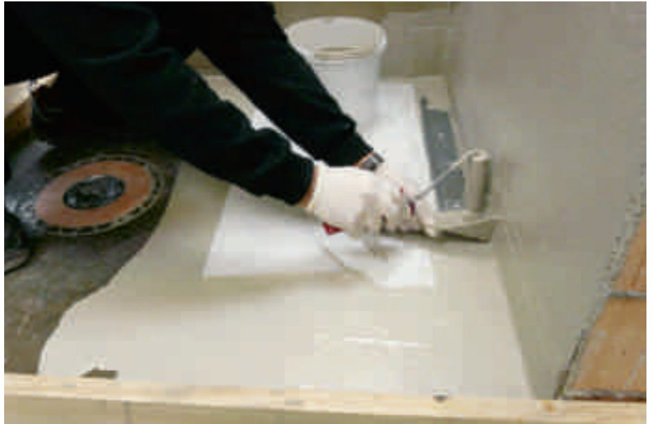
Praxisnaher Weiterbildungskurs: Die Teilnehmer konnten die Applikation von Flüssigkunststoffabdichtungs-Systemen eins zu eins üben.
