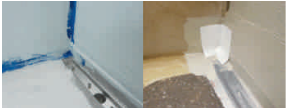
Eine besondere Herausforderung war das Abdichten der Raumecke mit direktem Rinnenanschluss.
