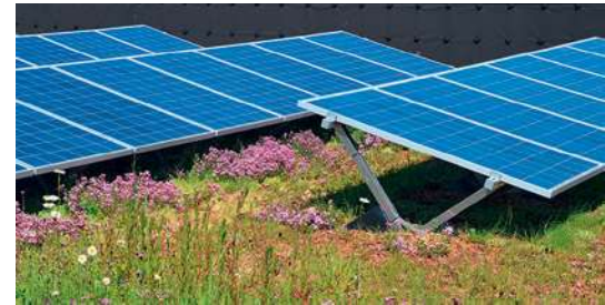
Toiture plate après travaux d'entretien.
