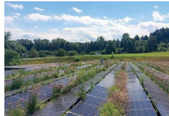
Toiture plate après un an sans entretien.
