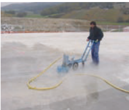
Hochdruckwasserstrahlen 750 bis 1000 bar.
