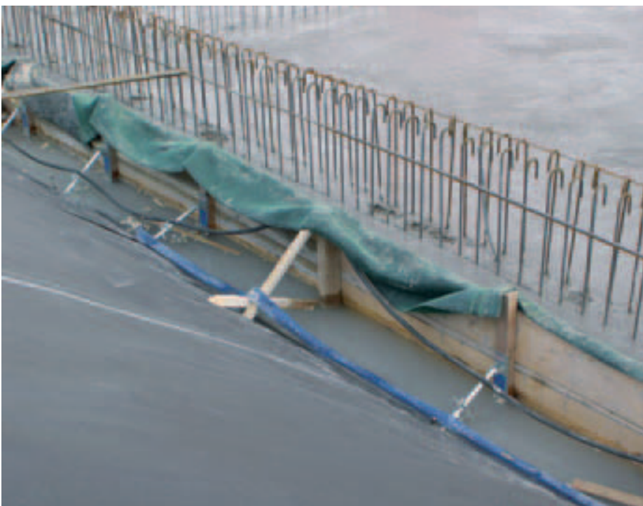
Betonplatte im Grundwasser: Die Wasserhaltung muss während der ganzen Bauzeit funktionieren!
