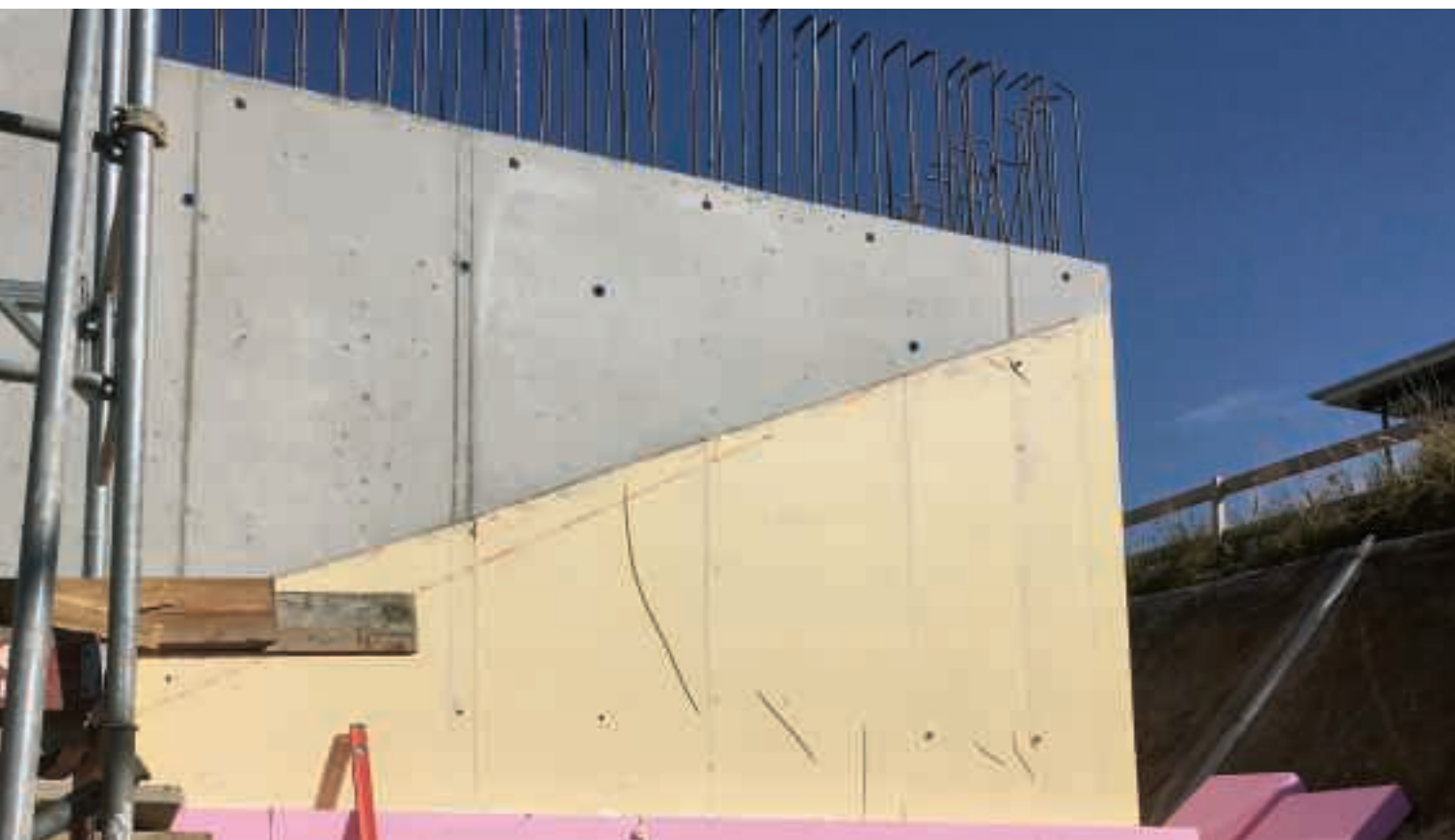
Mur avec membrane FPO partielle.
