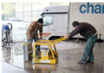
Der speziell modifizierte Rissfugenschneider im Einsatz.
