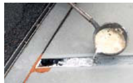
Ausgiessen der Fugen mit Zinn.
