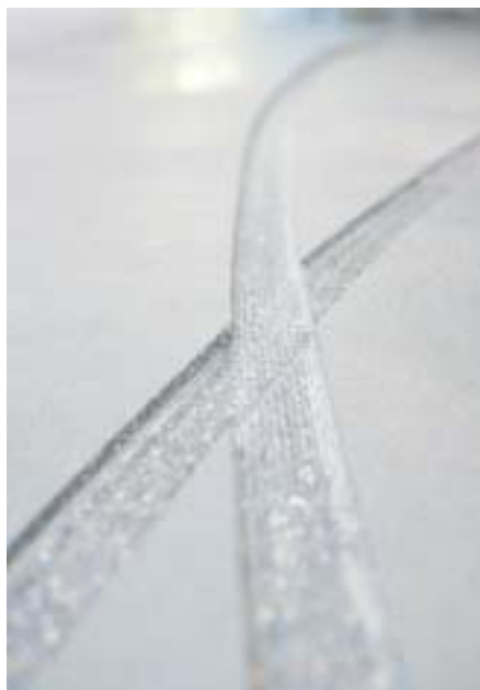
Ansicht der Fugen, die im Nassverfahren herausgefräst wurden.
