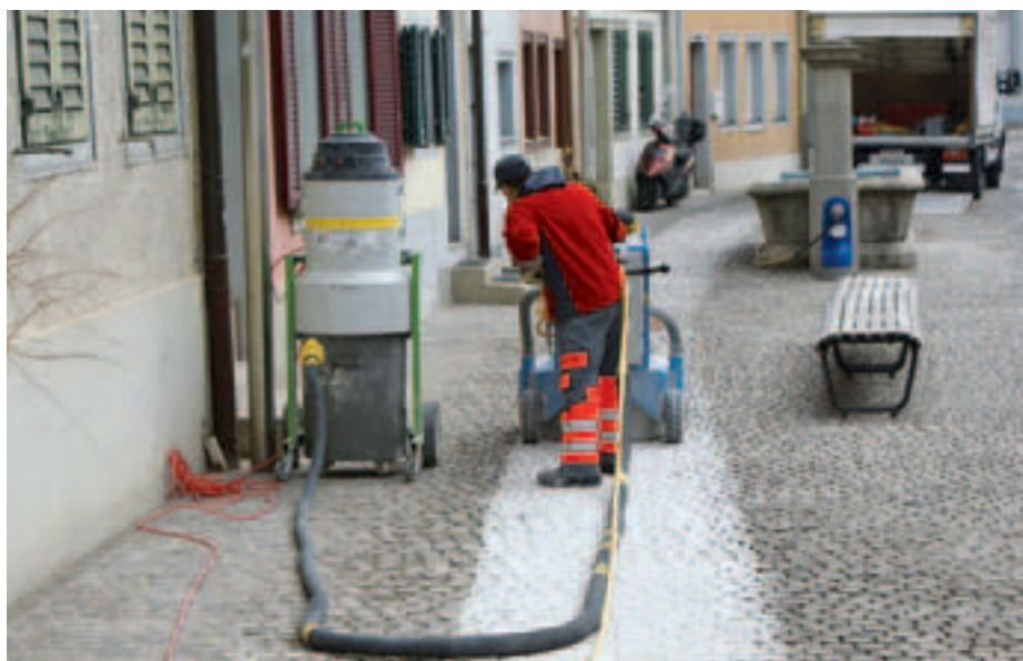
Zweiter Arbeitsgang mit der Spezialschleifmaschine.
