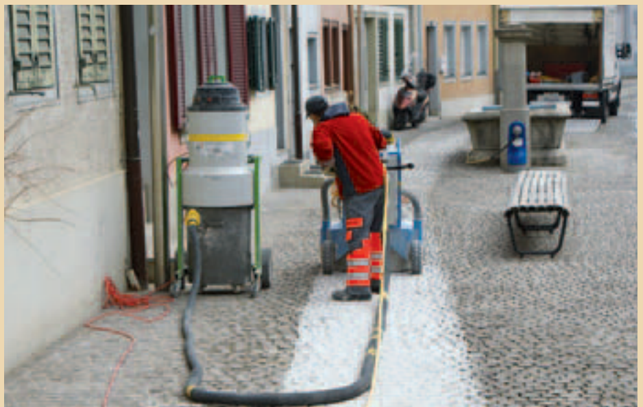
Deuxième étape de travail avec ponceuse spéciale
