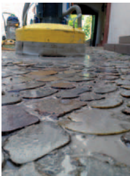
Erster Schleifvorgang mit Spezialmaschine.
