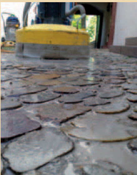
Première opération de ponçage avec machine spéciale
