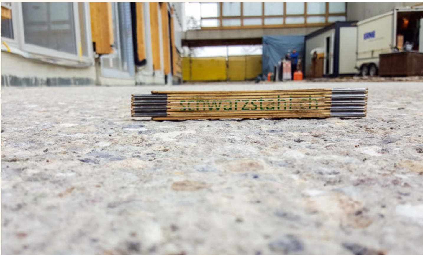
Surface béton après fraisage fin (et grenailage) avec un tambour de fraisage fin profondeur de rugosité 2,4 mm.
