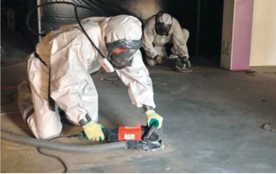
Asbestsanierung von Bodenbelägen
