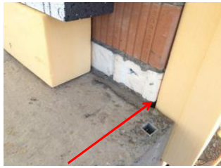
Fehlende Abdichtung. Wasser gelangt hinter die Isolation.
