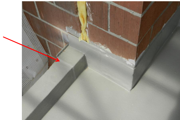
Korrekte Lösung: Abschluss mit Tasche Wasser bleibt auf dem Balkonboden
