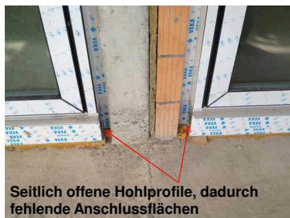
Versetzte Blendrahmen aufwändige Eckausbildungen
