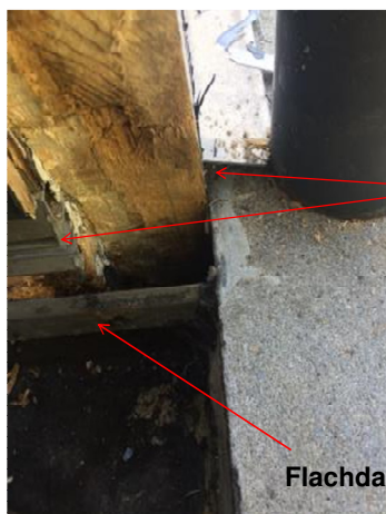
Fehlende Abdichtungen bei Betonbrüstung unter dem Wetterschenkel und horizontales Fensterprofil
