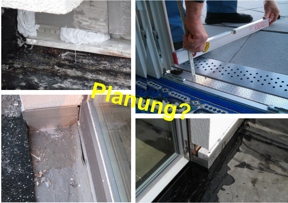
1. PAVIDENSA-Symposium «Schadenspotenzial von Planungsdetails»
