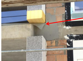
Balkonabschluss fehlende Taschen
