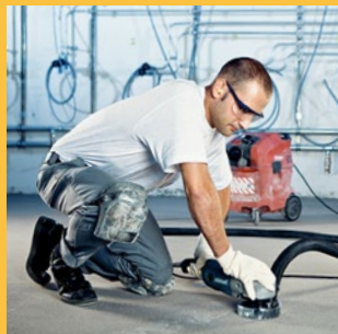
Les constructeurs/-trices de sols industriels et de chapes et ...
