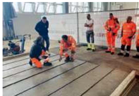
Die Fugen werden auf Trockenheit und Sauberkeit geprüft.
