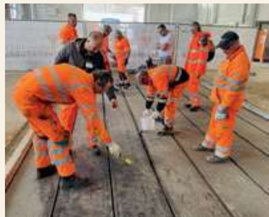
Die Fugen werden vermessen und grundiert.
