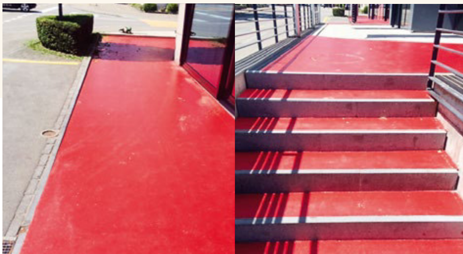
Polyurethanbeschichtung bei der Raiffeisenbank in Tägerwilen
