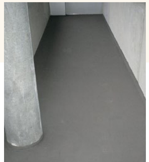
Acryldispersion-Beschichtung in der Binzmühle in Zürich.
