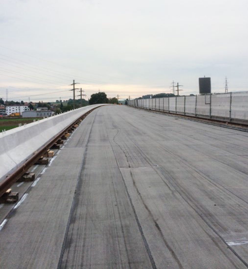
Abdichten der Flächen mit PBD-Bahnen.
