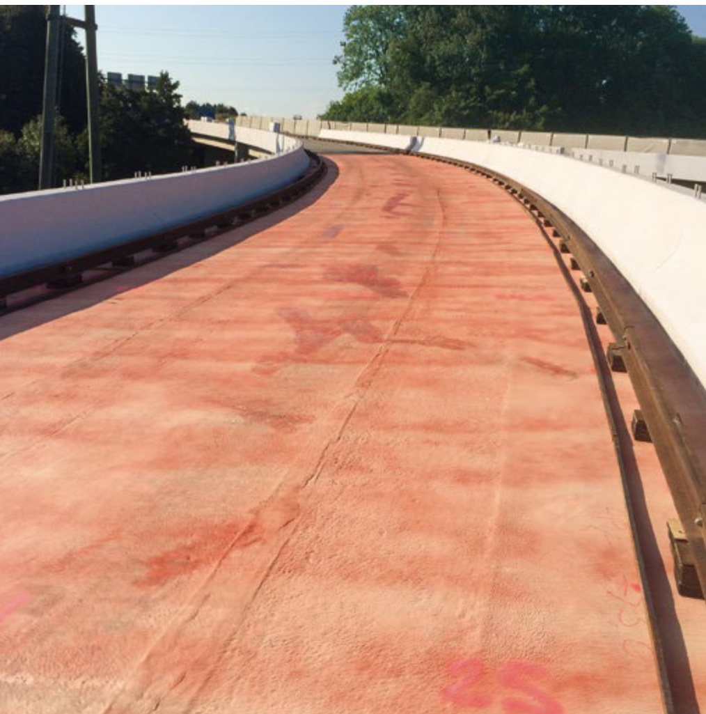
Abdichtung der Fläche mit Flüssigkunststoff.
