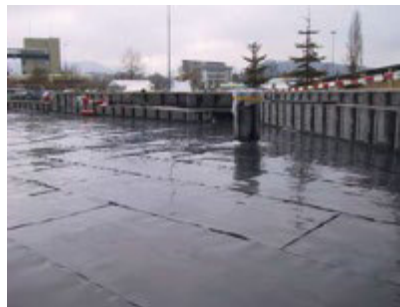
Befahrbare Schutzplatte auf Horizontalflächen Schichtdicke 2–10 mm
