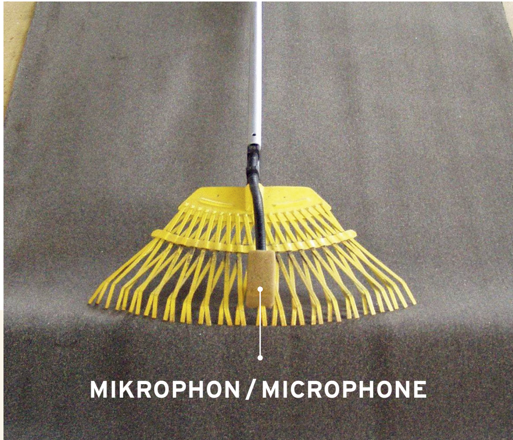
Figure 3: examen acoustique; détection de cloques dans le LBP à l'aide d'un râteau.
