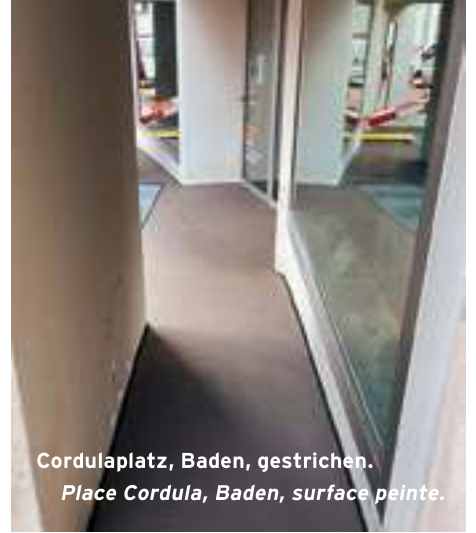
ZKB Neue Hard, Abstreung mit bit. Splitt. Banque cantonale zurichoise Neue Hard, saupoudrage avec gravillons bitumineux.
