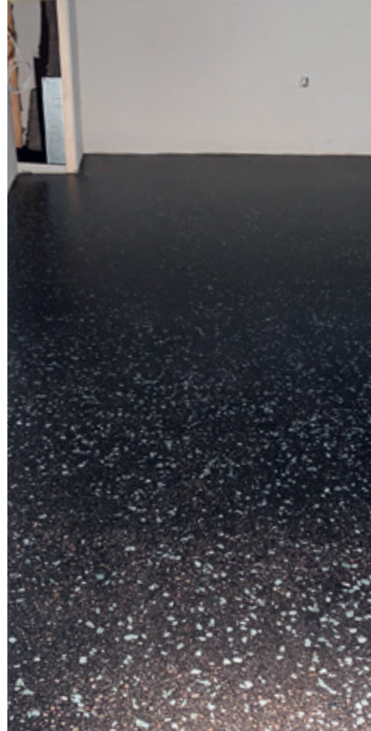
Geschliffener Boden inkl. Versiegelung.
