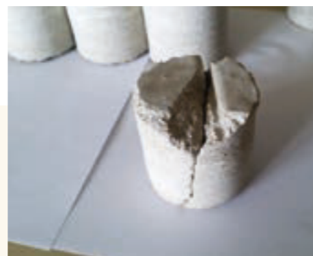
Carotte avec pli de film dans la zone de traction. De telles chapes ne supportent plus que des charges limitées (vous trouverez des informations plus détaillées à ce sujet dans la prochaine édition de la revue spécialisée).
