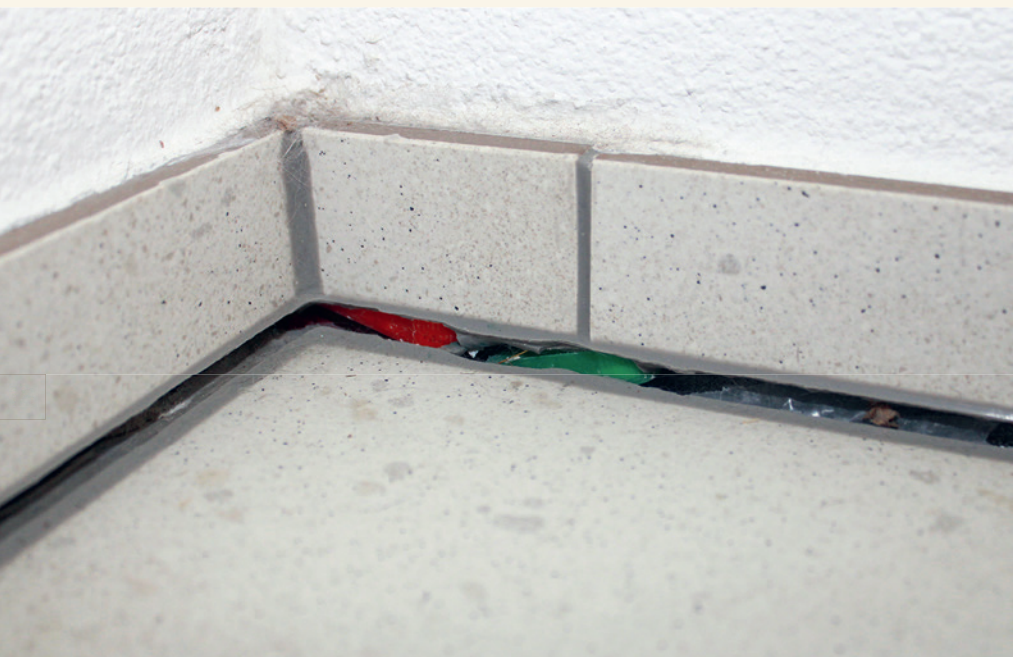
Abb. 3: Absenken des Bodenbelags vom Wandsockel.
