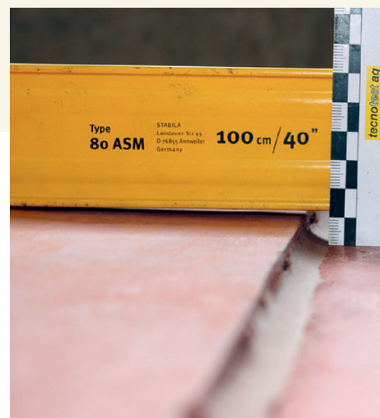
Abb. 1: 13 mm hoher Versatz bildet eine Stolperfalle am Belag.
