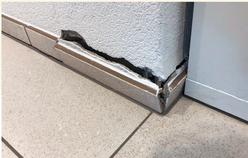
Abb. 5: Ablösen der fest mit der Fugendichtungsmasse verbundene Sockelplatte beim Absenken des Estrichs.
