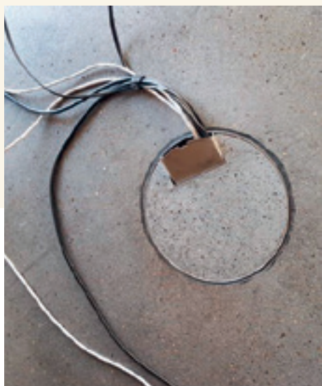
Bei den Bodendosen ist rund immer besser. Das Risiko auf Risse ist deutlich kleiner.
