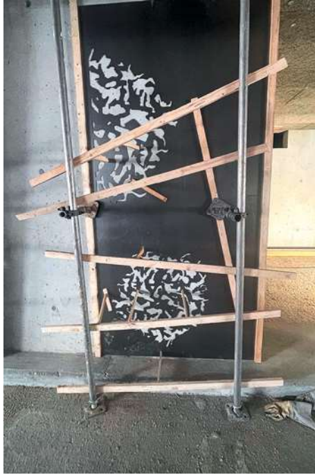
Abbildung 3: Fixierte Schablone auf Betonwand.
