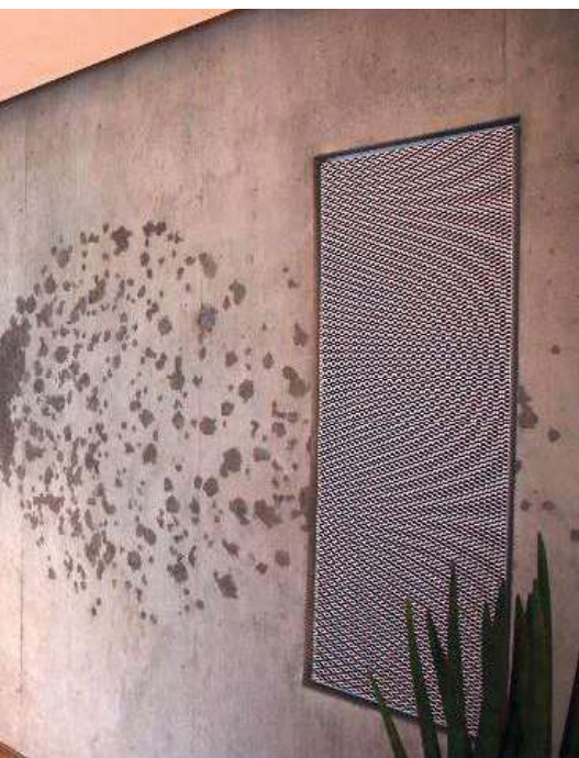
Image 1 : Béton sablé, empreinte négative sur un mur de bureau.
