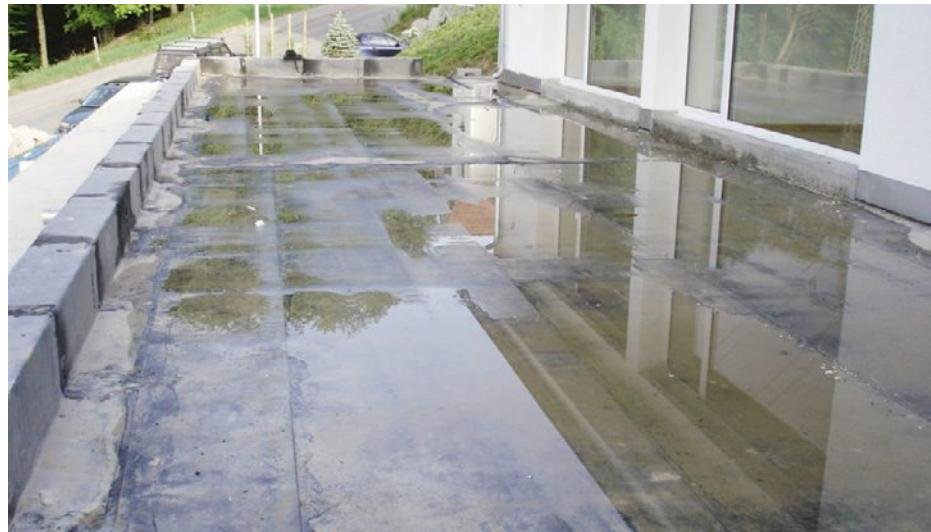
Aufgrund fehlerhafter Planung und Ausführung der (Unter-)Konstruktion können sich Wasserlachen bilden, was zu einer Überbelastung der Abdichtungen und zu einer elastischen Deformation der Bauteile führen kann.
