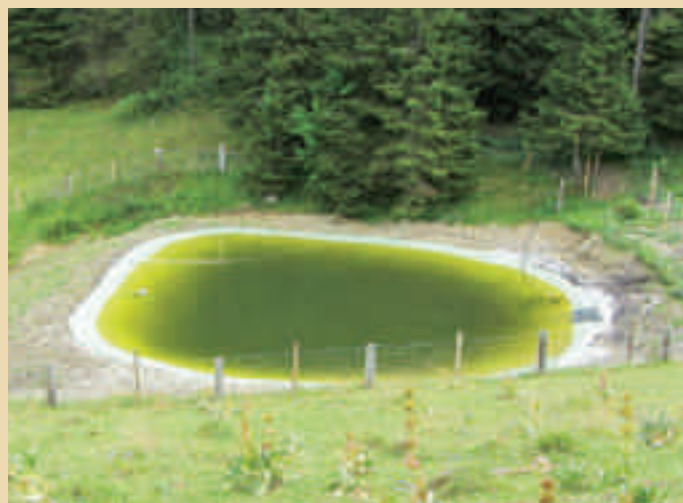
Images: Réalisation du bassin d'alpage de «La Grandsonne-Dessous» altitude 1'330 m. Capacité 350 m 3 . Exécution mai 2011 pour la commune de Grandson.
