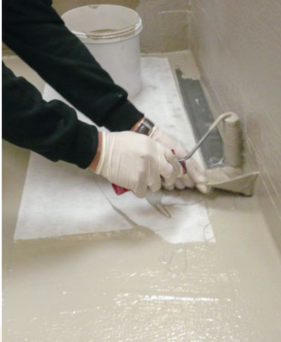
Raccord à la conduite d'écoulement en étanchéité en membranes synthétiques liquides
