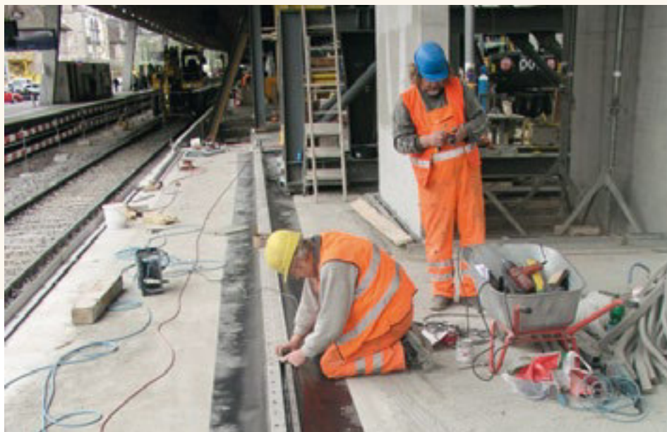
Installation des profils de recouvrement.
