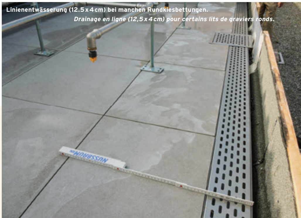
Verwendete grossformatige Keramikplatten (120 x 60 cm), Fugenbreite 3 mm. Carreaux en céramique grand format (120 x 60 cm). Largeur de joint 3 mm.
