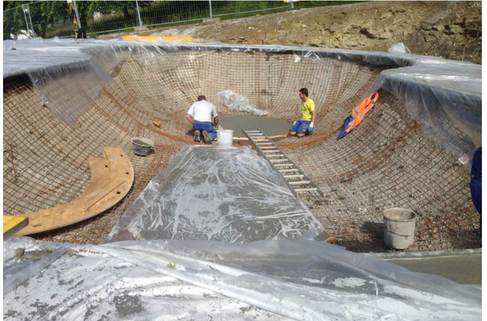
Beton- und Belagsarbeiten in 3D - Vorbereitung der «transitions» in der «bowl». Travaux de bétonnage et de revêtement en 3D - préparation des «transitions» dans le «bowl».
