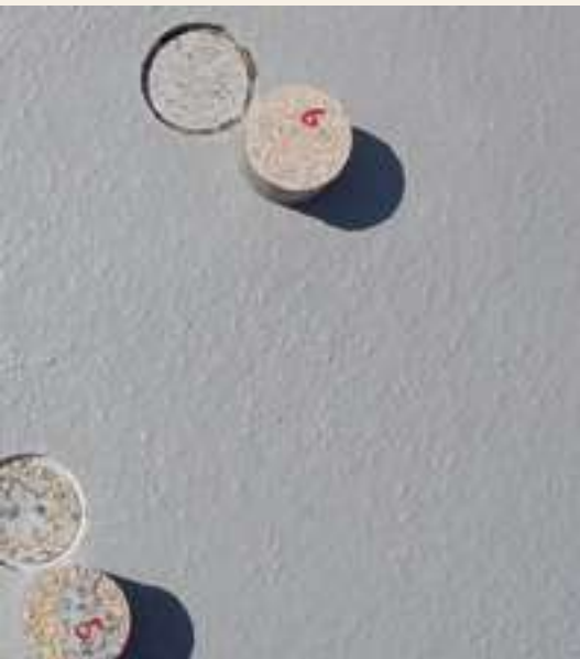
Essais d'adhérence du système de parking fini sur place.
