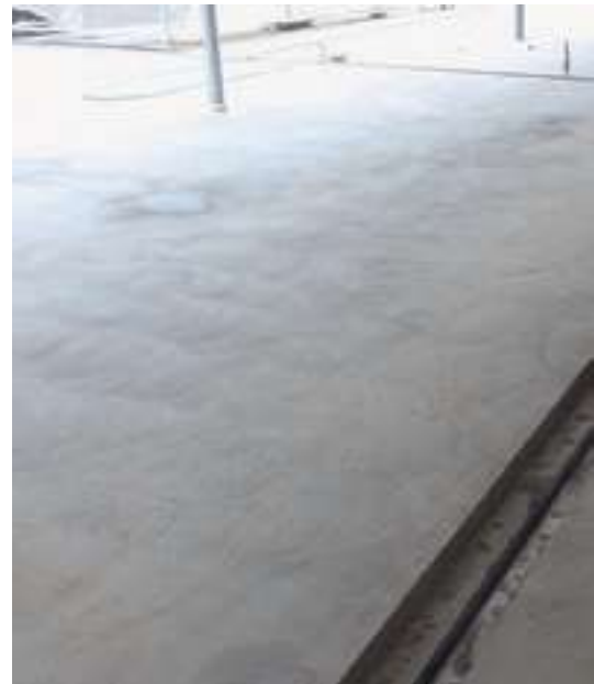
Ausbildung des Gefälles mit einem faserbewehrten Feinbeton anstatt eines Hartbetons.
