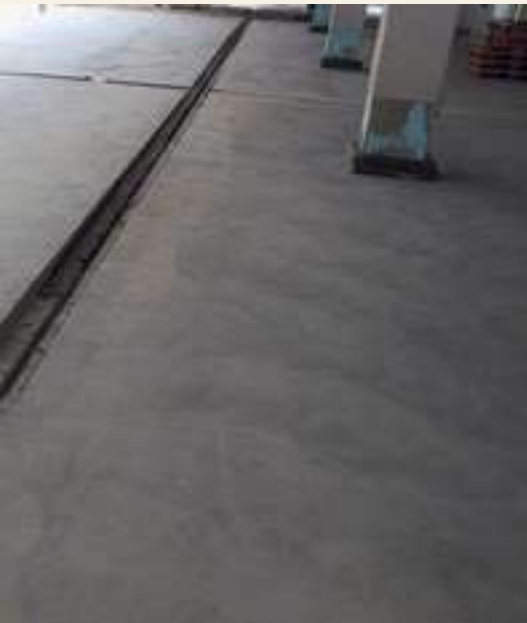
Pente formée avec un béton fin renforcé par des fibres au lieu d'un béton dur.
