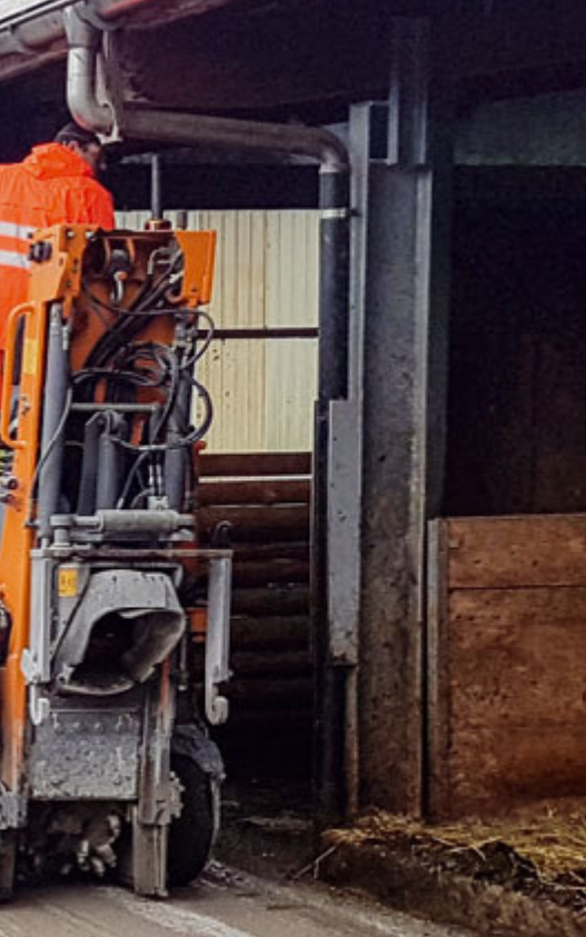
Kleinfräse in der 7 Tonnen Klasse beim Abtragsfräsen von Beton. Die Höhensteuerung wird von einem Flächenlaser übernommen.
