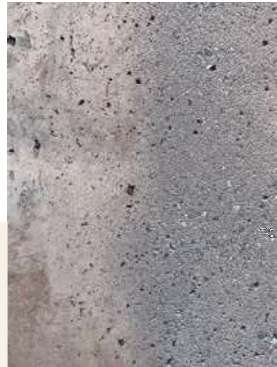
Illustration 1: Béton sablé, à gauche avant / à droite après.
