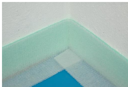
Angle intérieur parfaitement préparé
