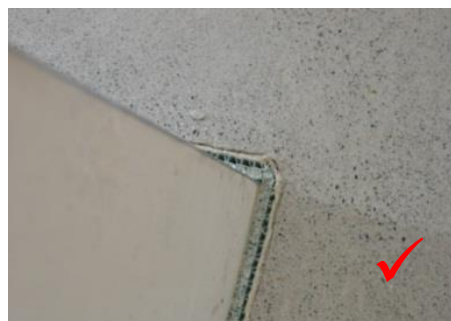
Voici un angle parfaitement bien exécuté. C'est le résultat à rechercher.
