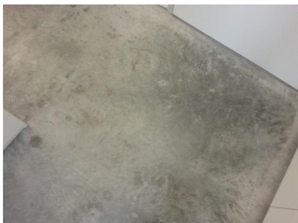
Une couverture inégale est toujours problématique. Le planning doit être établi de manière à ce que les surfaces puissent sécher à l'air libre.
