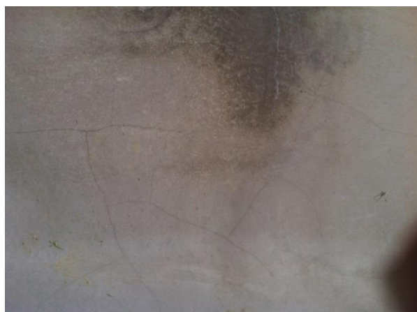
Des microfissures isolées jusqu'à une largeur de 0,1 mm doivent pouvoir être acceptées.
