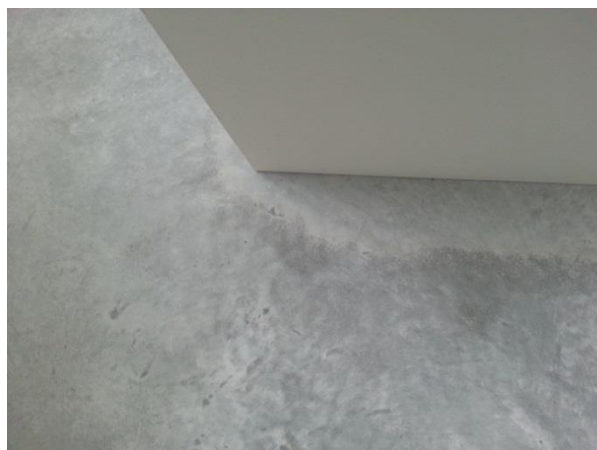
Une couverture inégale est toujours problématique. Le planning doit être établi de manière à ce que les surfaces puissent sécher à l'air libre.
