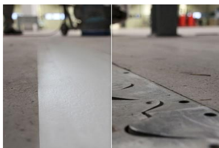
A gauche : joint RSL terminé, A droite : profilé de joint en acier
