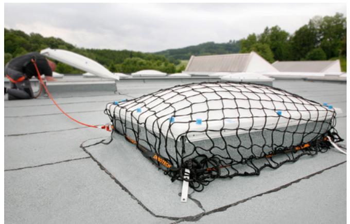
Fig. 39: Sécurisation temporaire d'une coupole de toit
