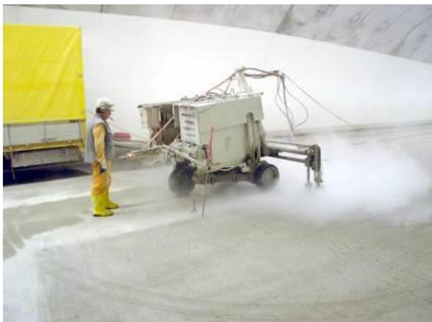
*Ici, il a fallu utiliser une artillerie plus lourde : Jet d'eau à haute pression à 2000 bars, enlèvement de 2-3 mm.*
